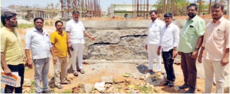
ఇంటిగ్రేటెడ్ నిర్మాణ పనులను పరిశీలిస్తున్న మున్సిపాలిటీ పాలకవర్గం సభ్యులు
